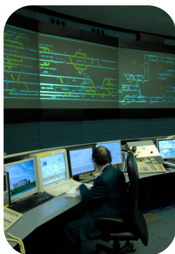
Signaux de commandes Ferroviaires
